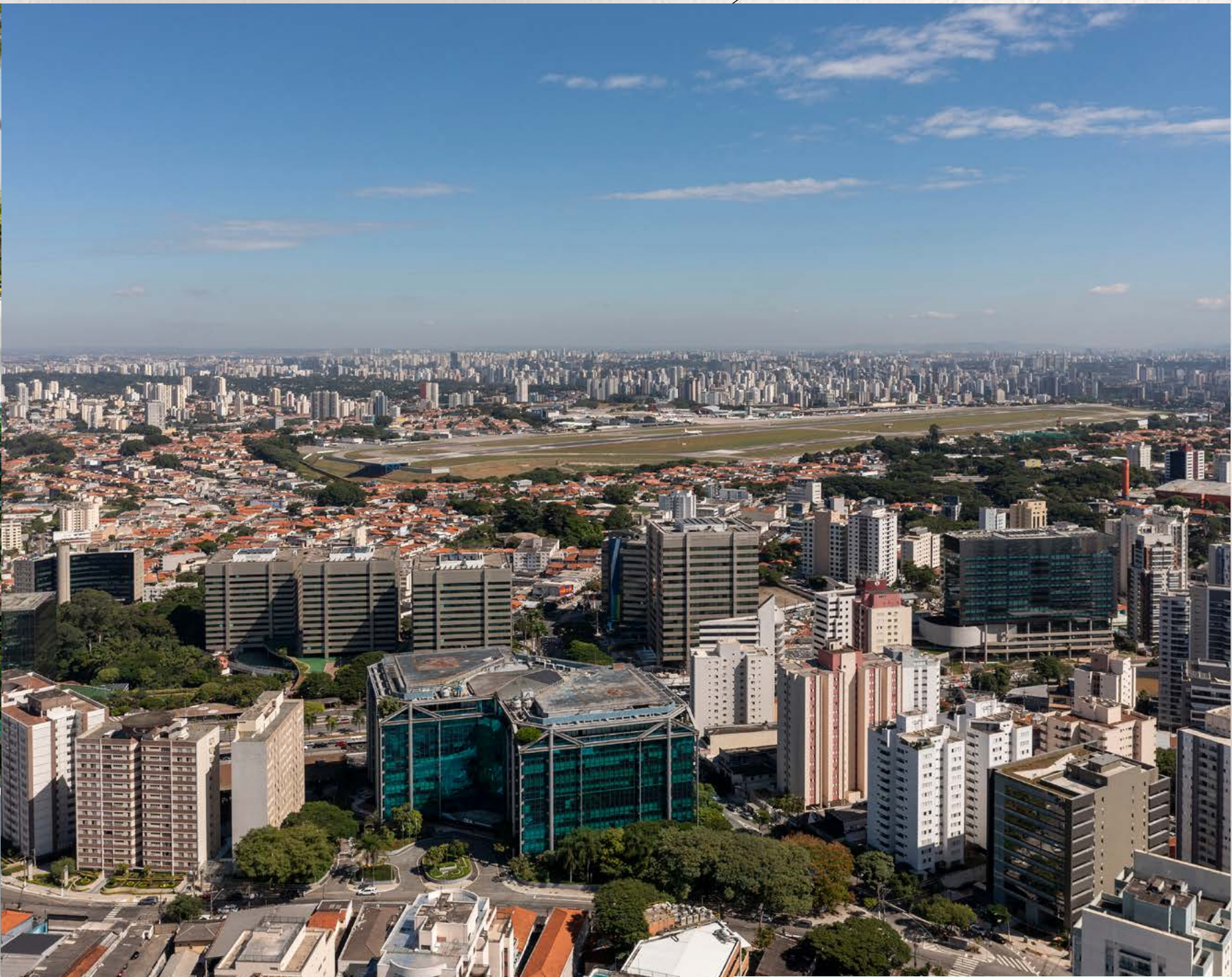
SEDE ITAÚ, CENTRO EMPRESARIAL DO AÇO E AEROPORTO DE CONGONHAS
